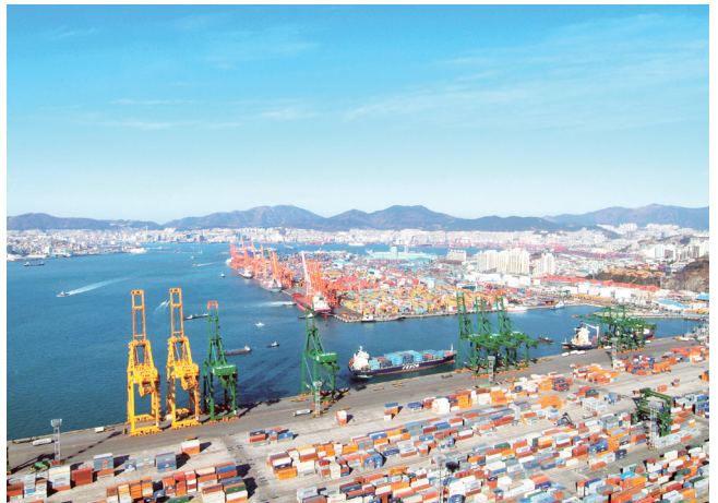
신선대부두 전경(부산항만공사 2010년대 말)
